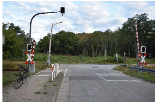
...Gleis Bahnübergang km 209,2 am westlichen Ende
