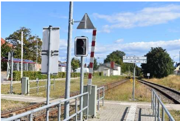
Fussgänger-Bahnübergang an Ostseite des Bahnhofs
