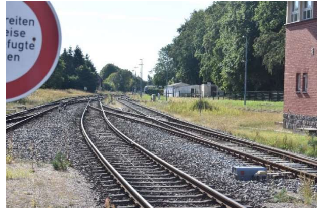
Gleisvorfeld hinter Ausfahrtsignalen
