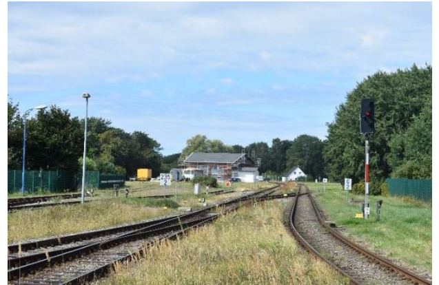
Rechts Ausfahrtsignal Ri. Peenemünde, im Hintergrund links der Betriebshof
