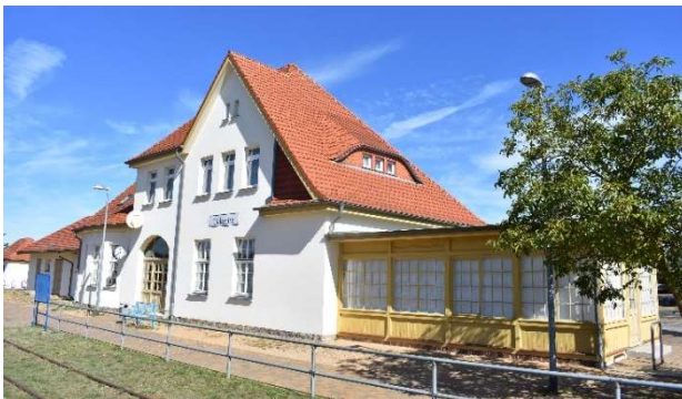
Die meisten Empfangsbäude an der Strecke sind renoviert/ in einem guten Zustand wie hier Ückeritz.
