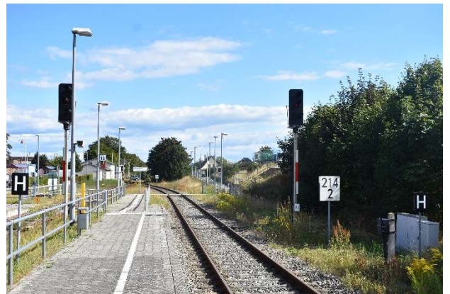
Ausfahrtsignale Bansin Richtung Heringsdorf,
