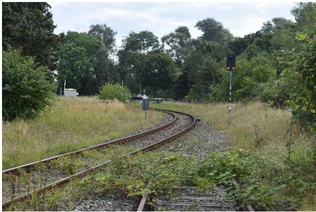
...heute nur noch mit Bahnübergangsüberwachungssignal
