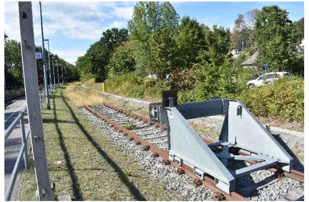
...das überwachte Stumpfgleis in Bansin
