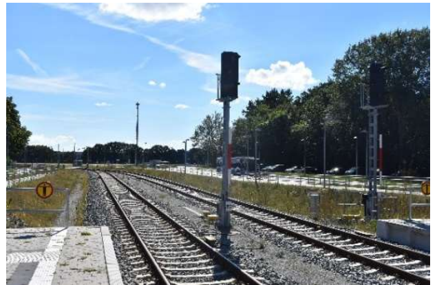
Schmollensee Ausfahrtsignale Richtung Heringsdorf mit BÜ km 218, 2
