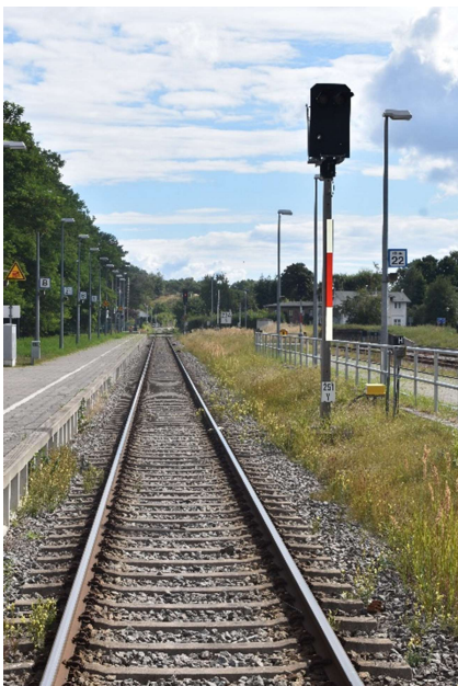
Ausfahrtsignal am Hauptgleis Richtung Heringsdorf, im Hintergrund die Bahnübergänge km 234,7 und 234,5
