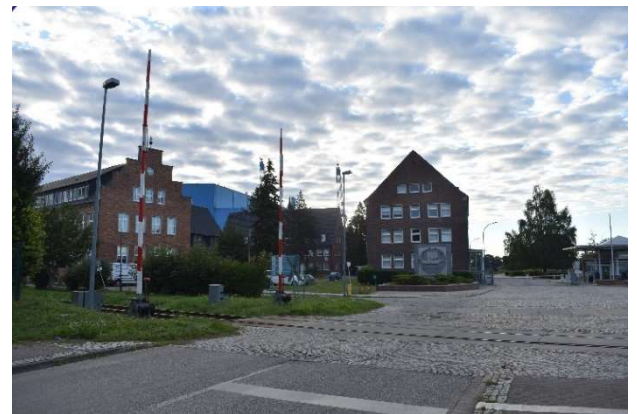
Bahnübergang östliche Bahnhofseneinfahrt km 210,2
