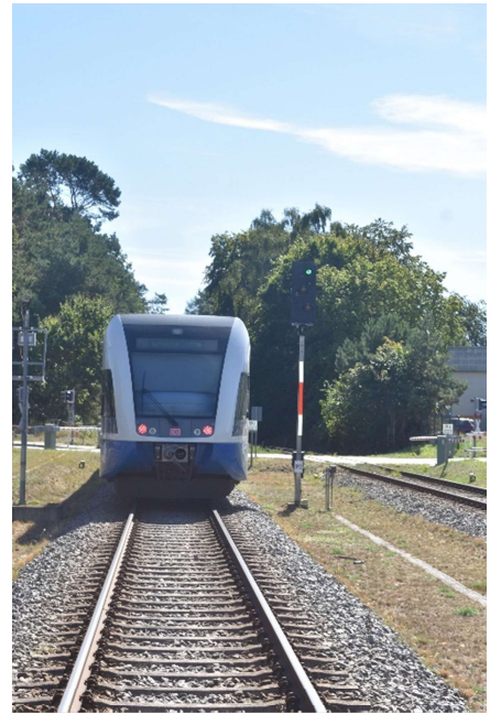
Ückeritz Richtung Heringsdorf, Bahnübergang km 222,1
